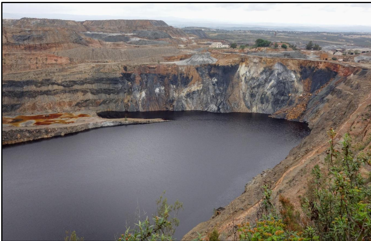
Vista del sector este de la corta Filón Norte con las instalaciones mineras al fondo.
