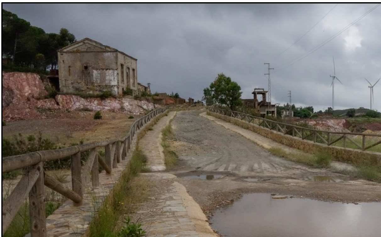
Restos de la casa de máquinas del pozo de Sierra Bullones al borde del camino.
