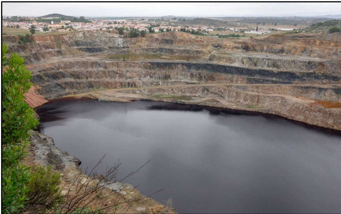
Vista del sector oeste de la corta Filón Norte con el poblado minero al fondo.
